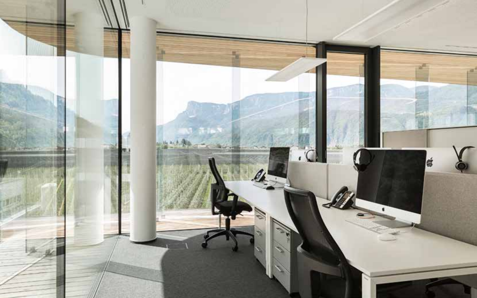
Abb.: Über 120 Exemplare der Büroleuchterserie »Task« wurden an den Bildschirmarbeitsplätzen installiert. Sie gewährleiten beste Sehbedingungen und eine bedarfsgerechte Lichtregelung.
